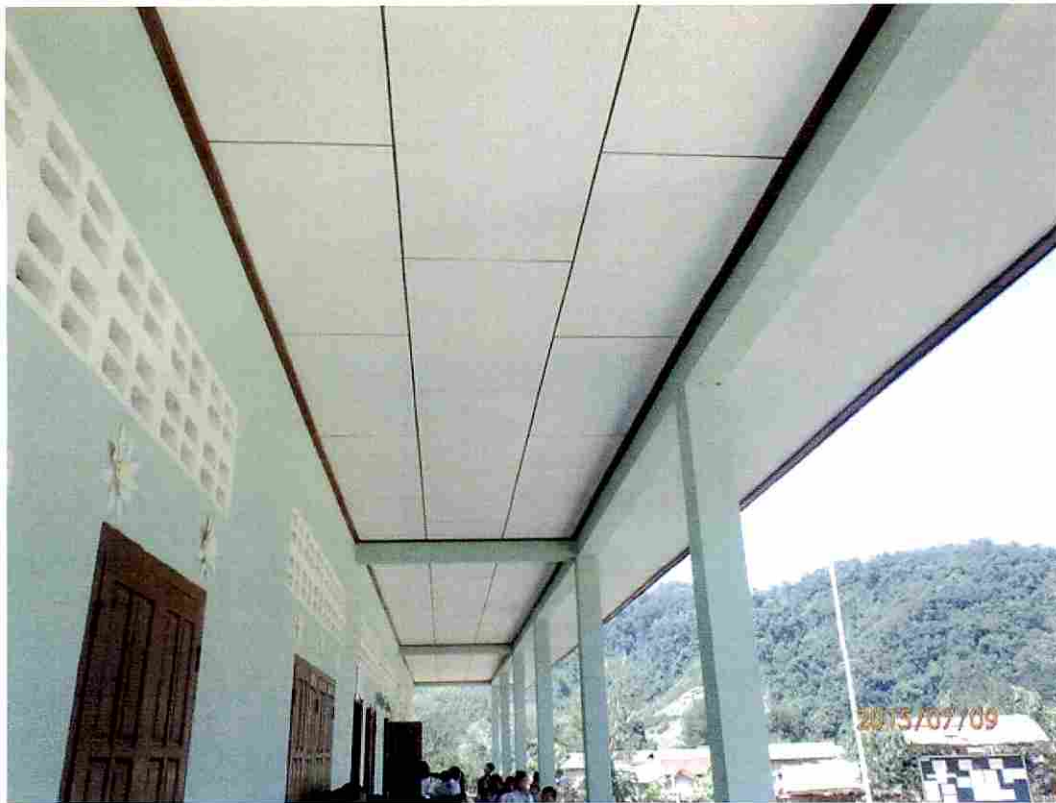
・教室前廊下の天井
